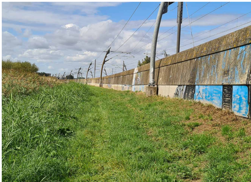
Figuur 9: Geluidsscherm Betuweroute als harde rand aan noordzijde
