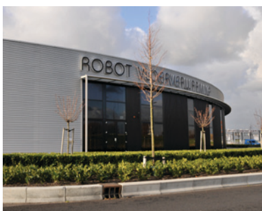
Bescheiden belettering ingepast in het gevelbeeld
