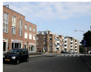
Groot gebouw aan de Zoutstoep heeft drie zichtbare lagen in de straatwand
