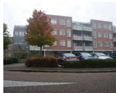
Uitzondering aan de Thorbeckelaan met meerdere lagen en een plat dak
