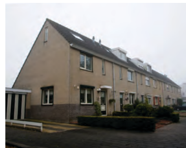
Korte rijen woningen van twee lagen met een zadeldak langs groene straten
