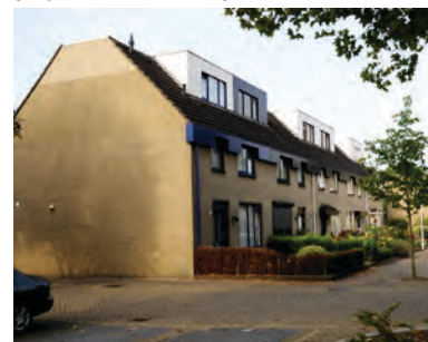
Dakopbouw op afgeknot zadeldak in combinatie met dakkapel in De Weren
