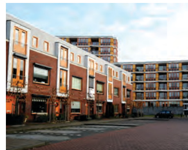
Nieuwbouw aan de Zuiderzeestraat heeft drie lagen met een plat dak
