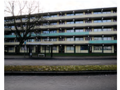
Zowel rijwoningen als flats richten op de belangrijkste openbare ruimte
