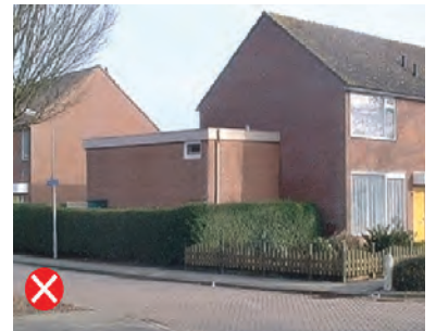
Zijaanbouw te hoog
