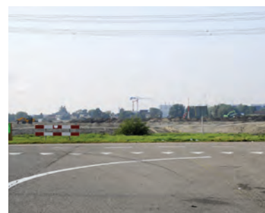
Baanhoek West is nu nog een bouwplaats
