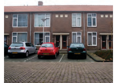
Gevels zijn van baksteen en soms voorzien van houten betimmering of puien
