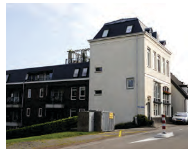
Hoofdgebouwen staan aan de dijk, bijgebouwen achter de voorgevelrooilijn
