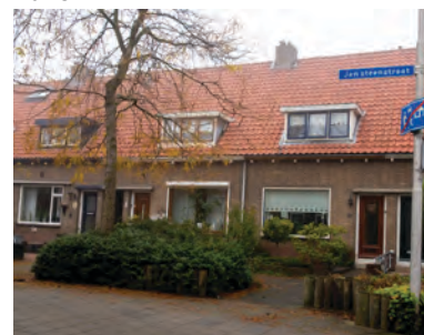
Aanbouwen vormgeven als ondergeschikt element
