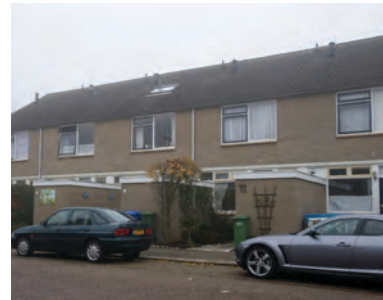
Woningen bestaan uit een onderbouw van één of twee lagen met kap
