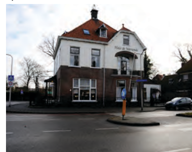
Gevels zijn in hoofdzaak van baksteen en soms gedeeltelijk gepleisterd
