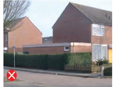
Zijaanbouw te dicht bij de voorgevelrooilijn
