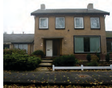
Elementen in een logische verhouding tot elkaar en de gevel plaatsen
