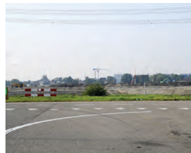
Baanhoek West is nu nog een bouwplaats
