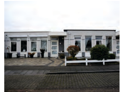
Verzorgde architectuur met eenvoudige zorgvuldige detaillering
