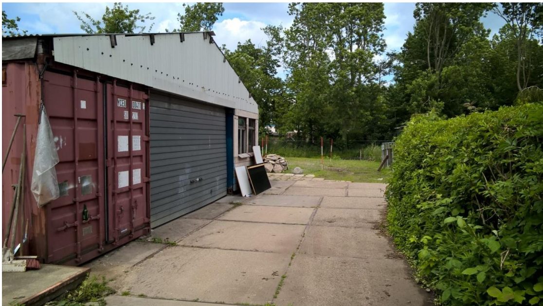
afbeelding 1: bestaande situatie in noordelijke richting (stelcon verharding en opstallen met er achter braakliggend terrein)
